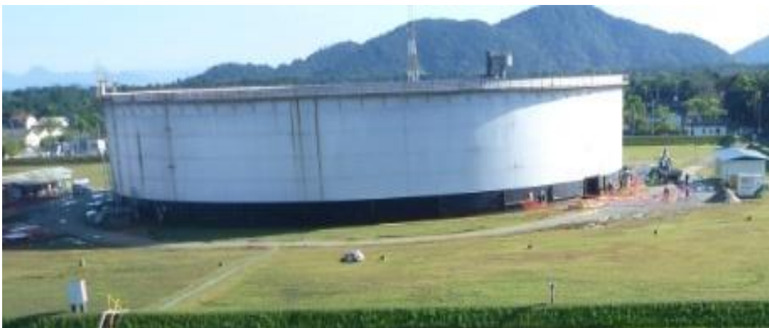
Figura 10 – Tanque de armazenamento de petróleo
