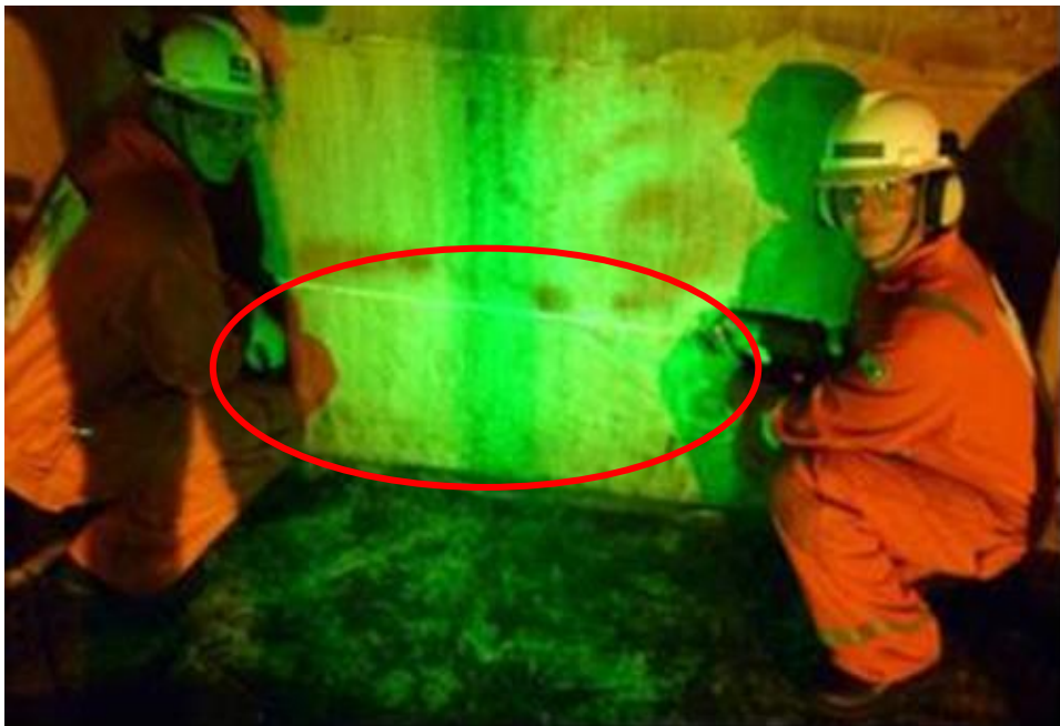
Figura 13 – Área de inspeção em de costado de tanque
